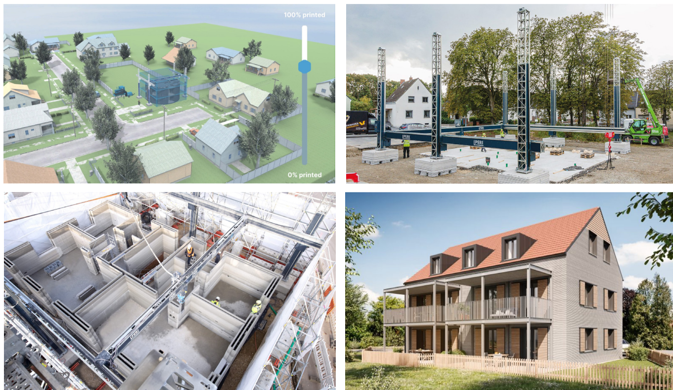
Рис. 9. Строительство компанией Beckit в Германии в 2020 г. трехэтажного дома с помощью тренажера 3D печати COBOD
