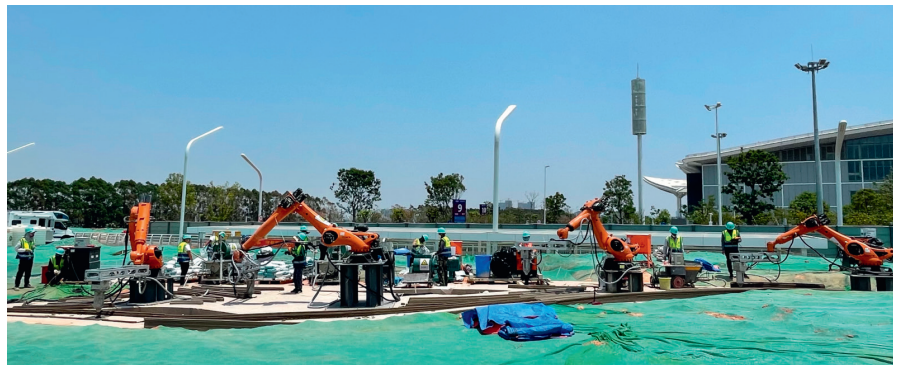
Рис. 25. Печать парковой архитектуры с помощью роботизированных принтеров смесями с использованием строительных отходов
