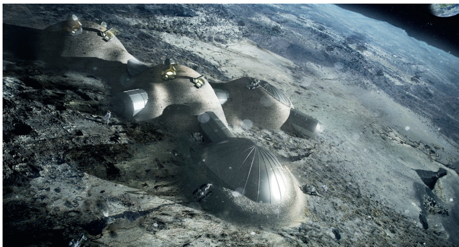
Рис. 29. Проект лунной базы из местного реголита, который будет напечатан принтером D-shape
