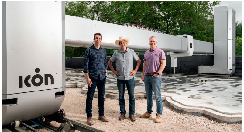
Рис. 6. Принтер ICON на строительной площадке
