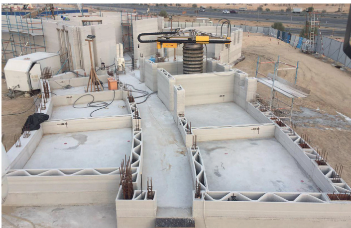
Рис. 5. 3D-печать здания
