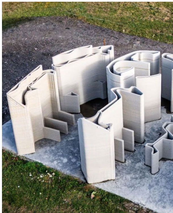
Фото: префабы на месте строительства
