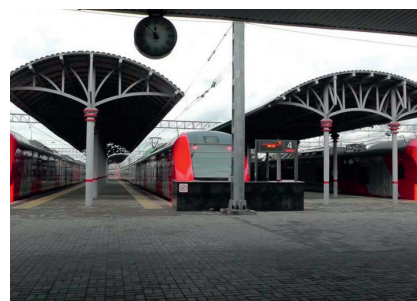
б) навес перрона Ленинградского вокзала (г. Москва) [6]
