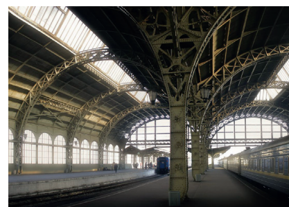
а) дебаркадер Витебского вокзала (г. Санкт-Петербург) [4]
