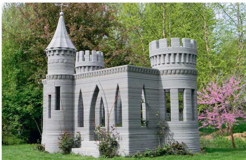
Рис. 10. Беседка, напечатанная Total Kustom в Калифорнии в 2014 г.
